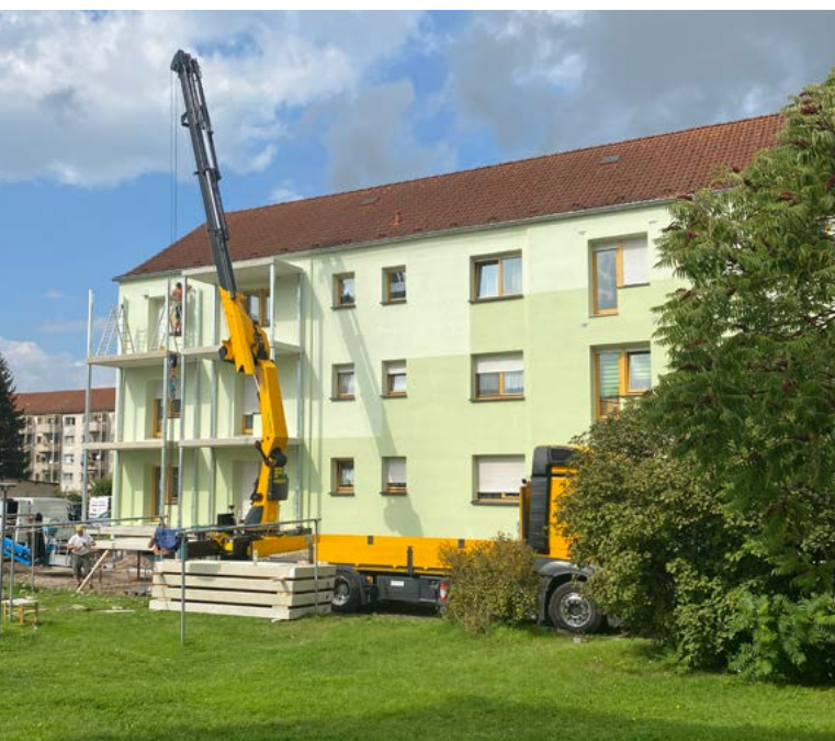
Anbau der neuen Balkone
