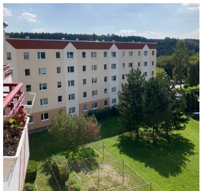
Fassadenreinigung Blankenhainer Straße
