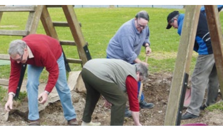
Instandsetzung der Spielgeräte
