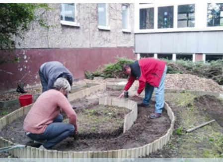
Neuaufbau der Fußföhlstrecke
